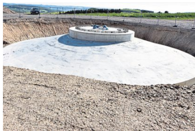
In unmittelbarer Nähe der Wüstung entsteht zurzeit der Windpark Pferdsfeld. Die riesigen Fundamente, die an fliegende Untertassen erinnern (unten, rechts), sind bereits betoniert. Eins der sieben Windräder liegt nahe an der Kirche Eckweiler (unten, links). Ein Bauzaun umgibt die von der Initiative Soonwald eingeweihte Bank um die alte Linde (Foto, oben) – dahinter das letzte noch erhaltene Haus, das bald abgerissen wird.
